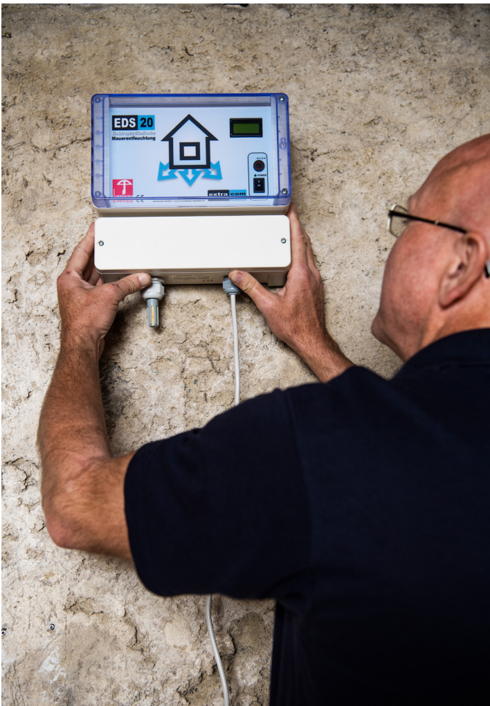
Das Electronic Dry System (EDS) wird ohne Eingriff in die Bausubstanz installiert.
